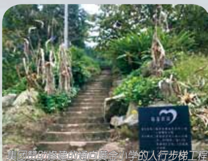
集团赞助修建的洒口黄金小学的人行步梯工程
