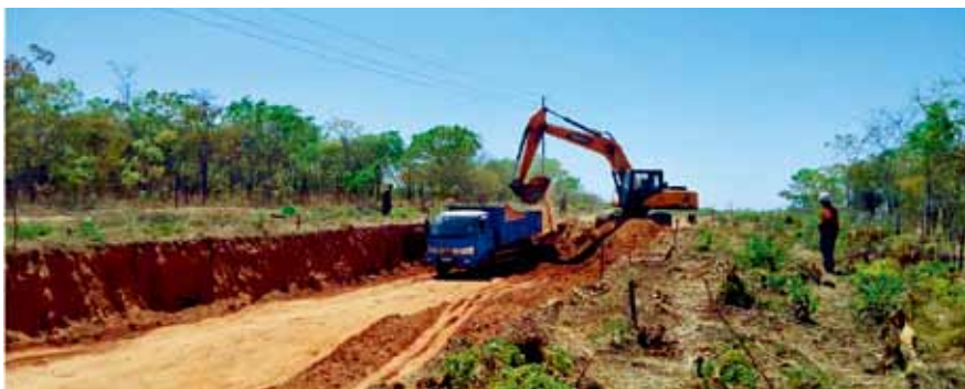
工业园前期施工照片
